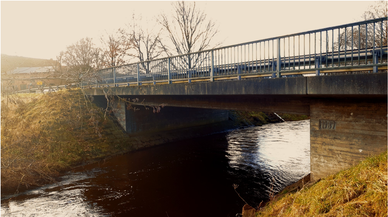
Bild 1: Die Störbrücke bei Padenstedt, fotografiert im Januar 2022
